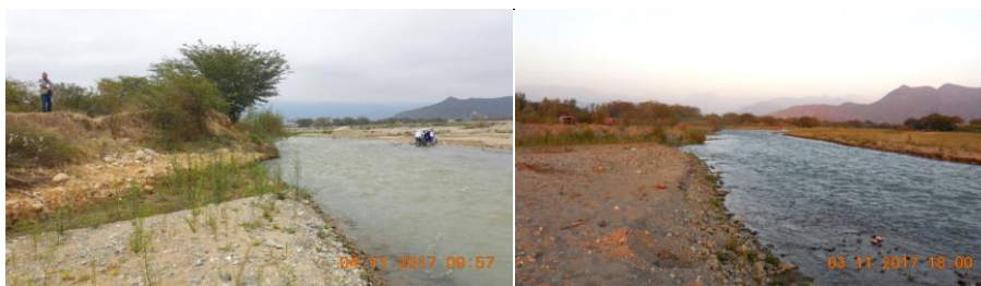
Vista: Sectores de las márgenes de río Olmos que no cuenta con obras de protección hidráulica.
